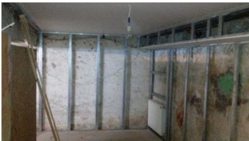
Pomieszczenia socjalne w trakcie remontu
